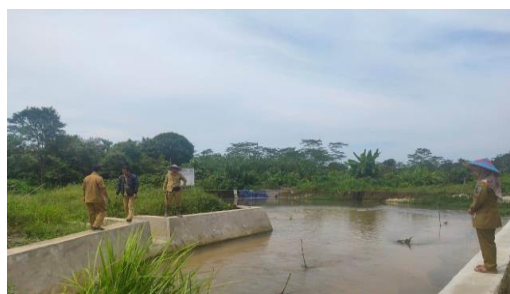
Pembuatan Bangunan Pelimpah dan Saluran Irigasi Sawah Dusun Mentigi
