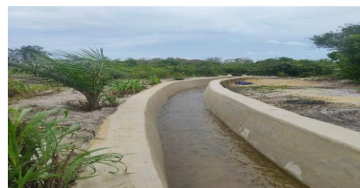
Pembangunan Irigasi Sawah Tanjung Rusa
