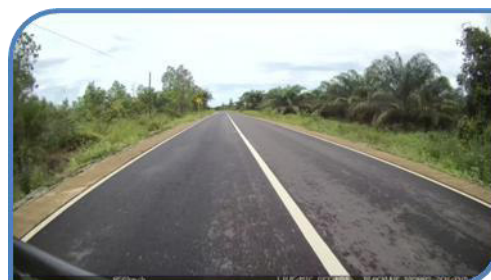
Pelebaran Jalan Mempiu - Petikan
