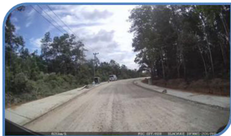
Pelebaran Jalan Air Mungkui-Mempiuk
