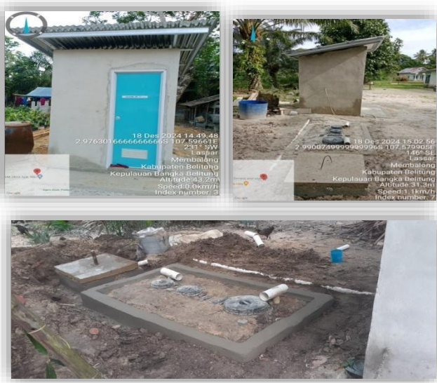
Gambar 2.7.: Kegiatan Pembangunan SPALD
